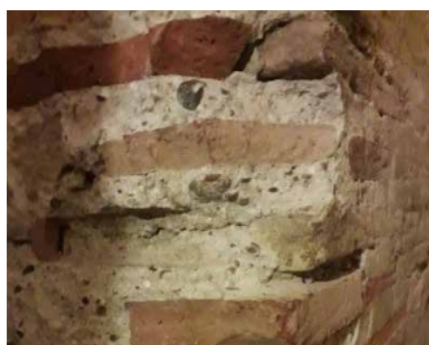
Mur de briques montés avec des mortiers à la chaux durables
