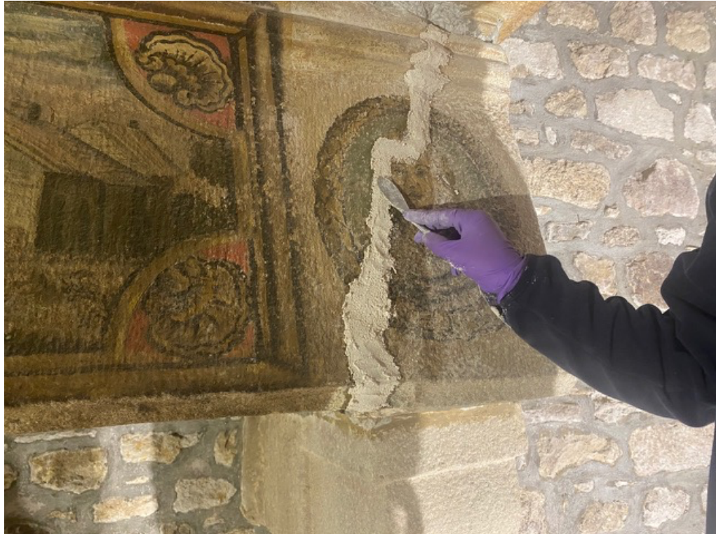
Pose d'un mortier de chaux, ©Géraldine Fray
