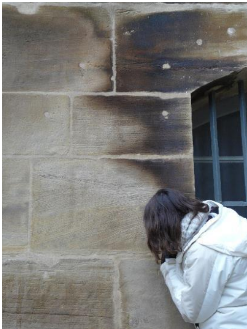
Château de Lunéville ; patines manganésifères affectant les parements en grès. (photo J.-D. Mertz, LRMH)
