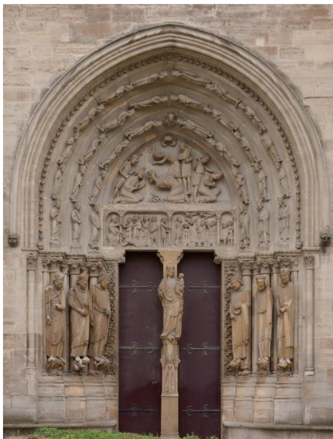
Portail des Valois, basilique Saint-Denis, 2015; le haut du portail a été nettoyé par compresses, nébulisation et micro-abrasion, tandis que le bas a été nettoyé par laser, engendrant des contrastes de couleur notables. (photo D. Bouchardon, LRMH)
