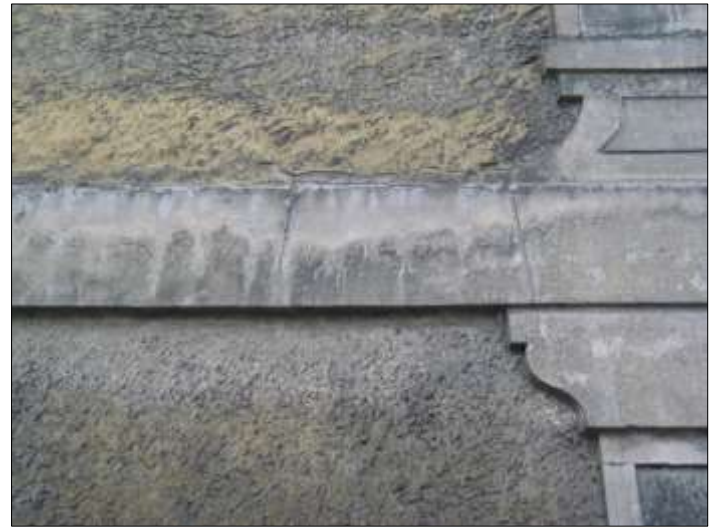
Façades du château de Janvry (Essonne) en enduit de plâtre, modénatures en appareil de pierre simulé et tapisseries en jetis de plâtre teinté dans la masse de couleur gris.
