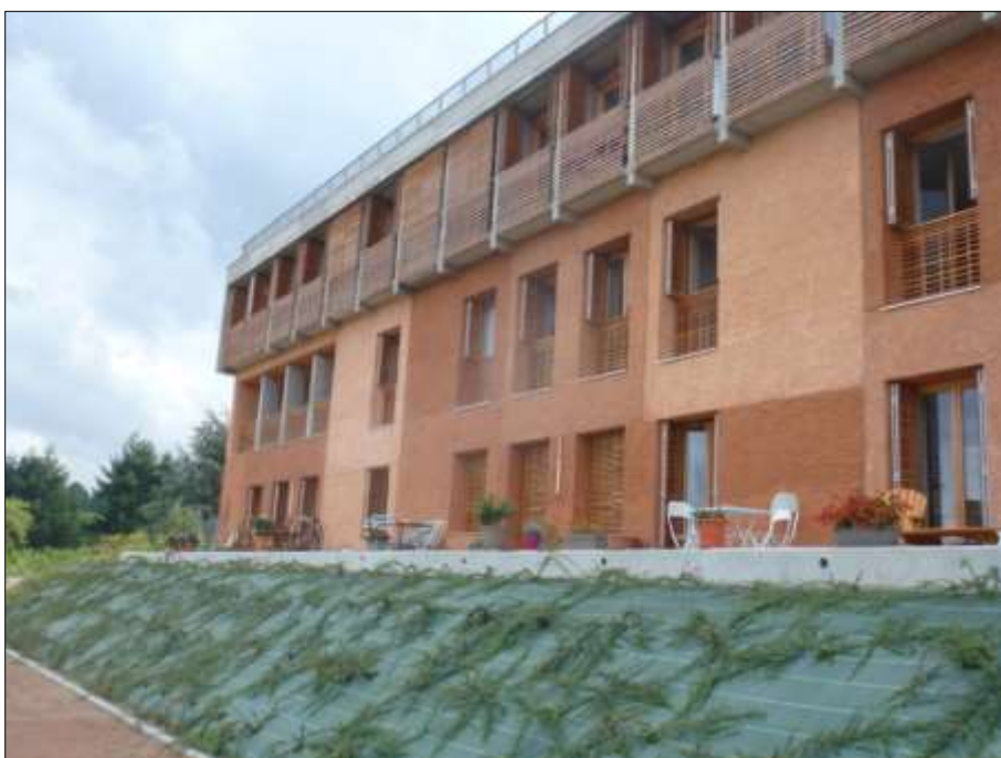
Plâtre teinté sur ITE (Isolation Thermique par l'Extérieur).
