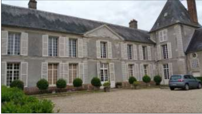
Façades du château de Janvry (Essonne) en enduit de plâtre, modénatures en appareil de pierre simulé et tapisseries en jetis de plâtre teinté dans la masse de couleur gris.
