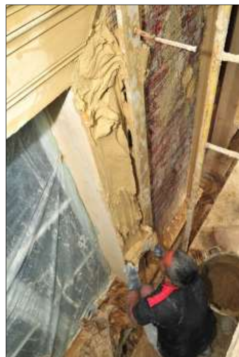
Stuc pierre d'intérieur, plâtre coloré avec joints en plâtre blanc. Réalisation in situ des décors linéaires moulurés en stuc pierre (plâtre teinté dans la masse et charges minérales).
