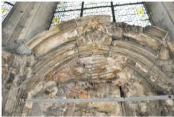
L'Arc central sous la fenêtre Ouest
