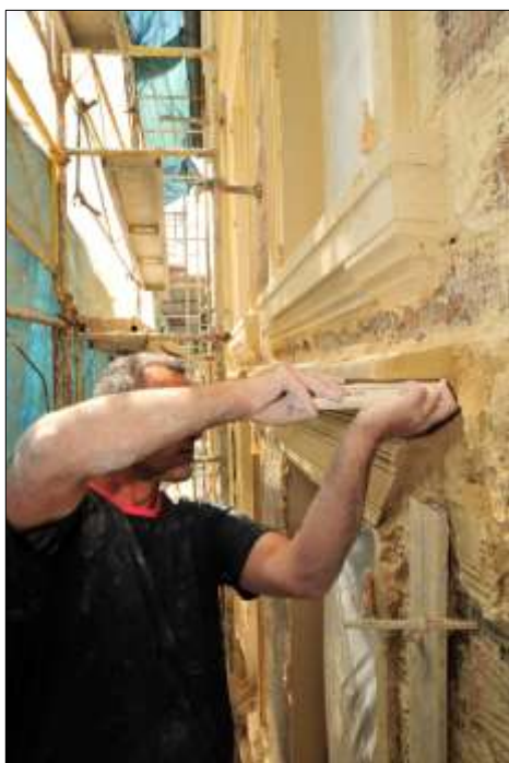
Stuc pierre d'intérieur, plâtre coloré avec joints en plâtre blanc. Réalisation in situ des décors linéaires moulurés en stuc pierre (plâtre teinté dans la masse et charges minérales).
