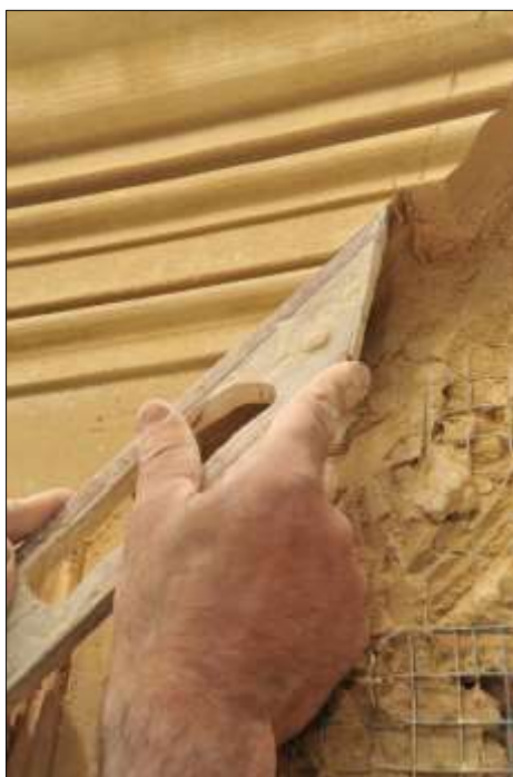
Stuc pierre d'intérieur, plâtre coloré avec joints en plâtre blanc. Réalisation in situ des décors linéaires moulurés en stuc pierre (plâtre teinté dans la masse et charges minérales).
