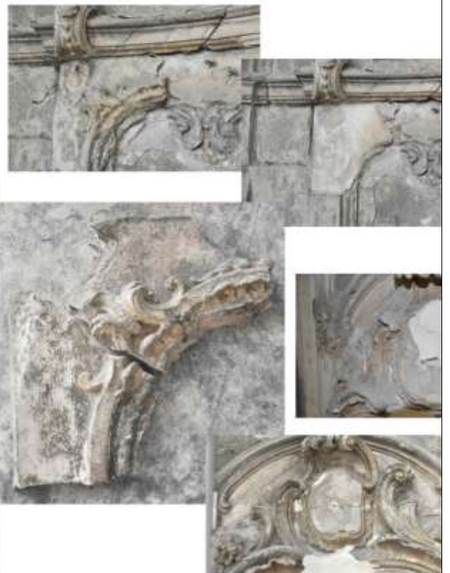
Dépense de fragments divers et recollage à la résine époxyde le long des corniches
