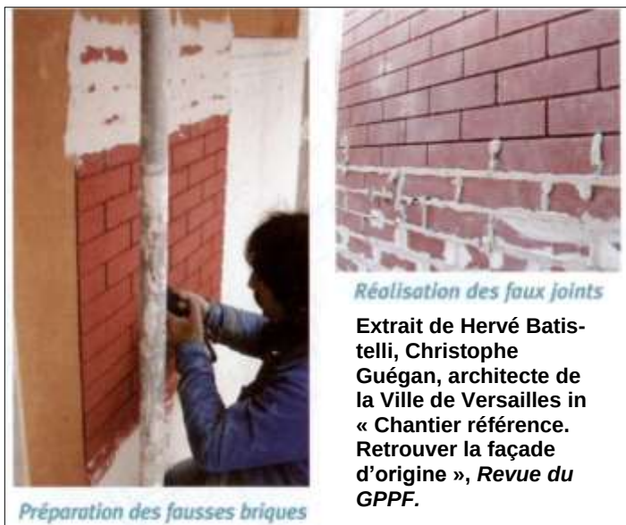
Façade en pan de bois à Versailles. Enduit de plâtre coloré type stuc brique et appareils de pierre simulé en plâtre ocrés.
