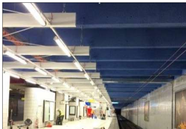
Plâtre de protection incendie, bleu dans la masse.
